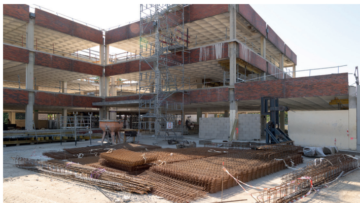
Rénovation lourde du collège Alfred Sisley à l'Île-Saint-Denis
